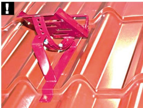
Die Montage einer Trittstufe analog durchführen. Jedoch sind die Trittstufen direkt an der Stütze anzubringen (ohne die bei dem Dachtritt verwendete Befestigung).
