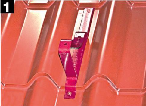
Die Stütze (Typ BD 350, 400) auf das befestigte Dachziegelblech legen und direkt an der hölzernen Dachkonstruktion festschrauben. Alle montagebedingte Löcher mit einem für Dachdeckerarbeiten bestimmten Dichtstoff abdichten.
