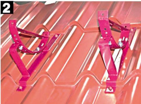
Die Befestigung des Dachtritts auf die Stütze legen und in die Horizontale bringen. Beide Elemente mittels beiliegender Befestigungsschrauben – 2 Stück pro Stütze - miteinander verbinden.
