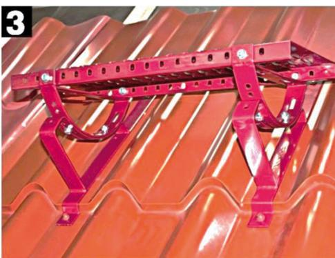
Nach Befestigung beider mit den Richtwiegen bestückter Stützen den Dachtritt für Schornsteinfeger anschrauben. Anschließend die angebrachte Vorrichtung auf die richtige Ausführung, insbesondere auf die Stabilität sämtlicher mechanischen Verbindungen, prüfen.
